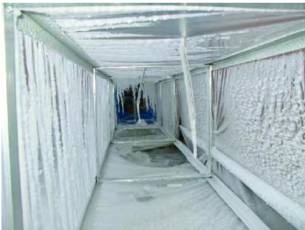
Рисунок 1.14 – Фото нарастающего слоя льда на стенках канала
